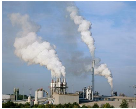
Fàbrica generadora d'Energia elèctrica.
